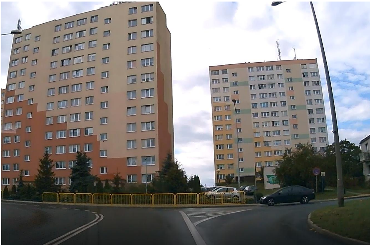
Ryc. 6 Widok skrzyżowanie ul. Bydgoskiej z ul. Kalinkową
