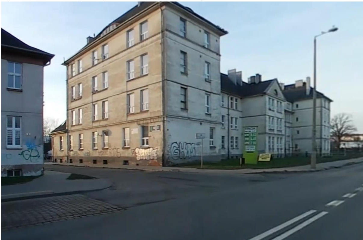
Ryc. 7 Widok na zabytkową zabudowę zlokalizowaną wzdłuż ul. Karabinierów
