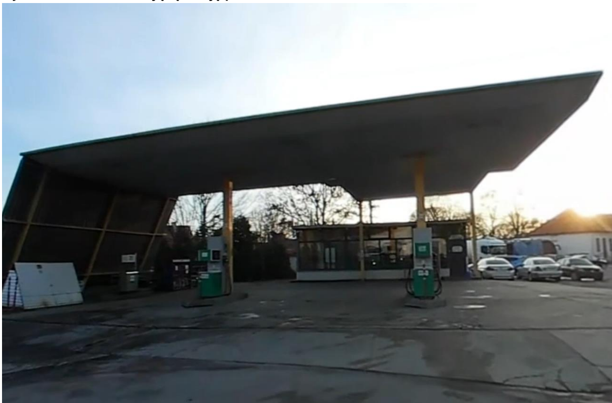
Ryc. 10 Widok na istniejącą stację paliw
