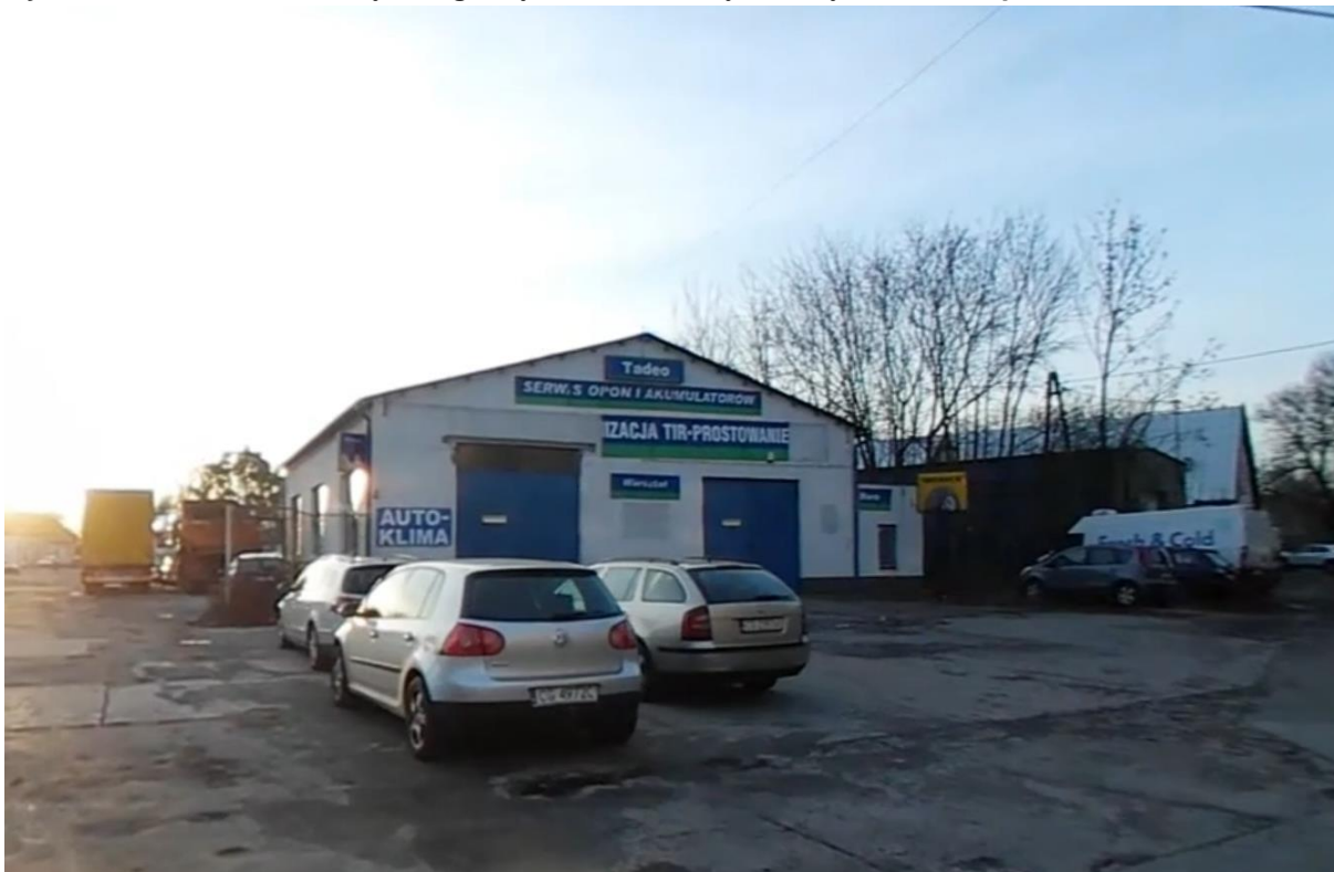
Ryc. 9 Widok na zabudowę usługową zlokalizowaną wewnątrz obszaru planu
